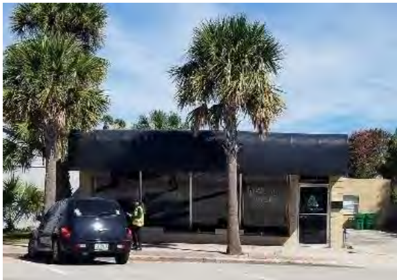
604 E New Haven Ave
